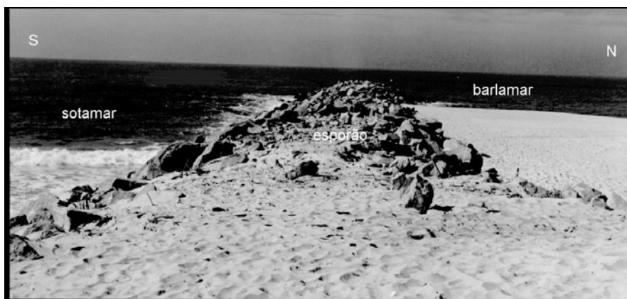
Foto 7 – Consequência da interposição de um esporão ao livre trânsito de sedimentos, na costa ocidental portuguesa.
