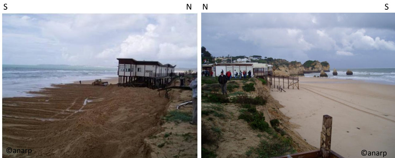
Fig.1 – Praia de Alvor dia 24 de Fevereiro de 2008, às 11.30h. Notar o volume de areia removido, tendo em atenção a altura da estacaria que suporta o apoio de praia e a posição alcandorada da rampa de acesso à praia.
